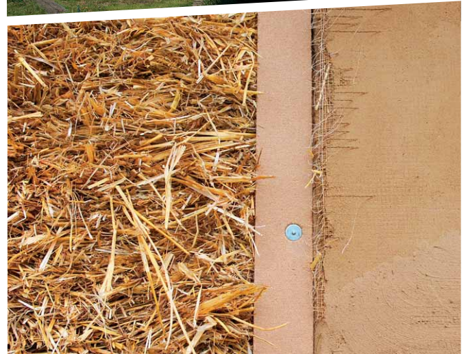
Mehrgeschossiges Gebäude in Holz-Strohbauweise – Norddeutsches Zentrum für nachhaltiges Bauen in Verden
