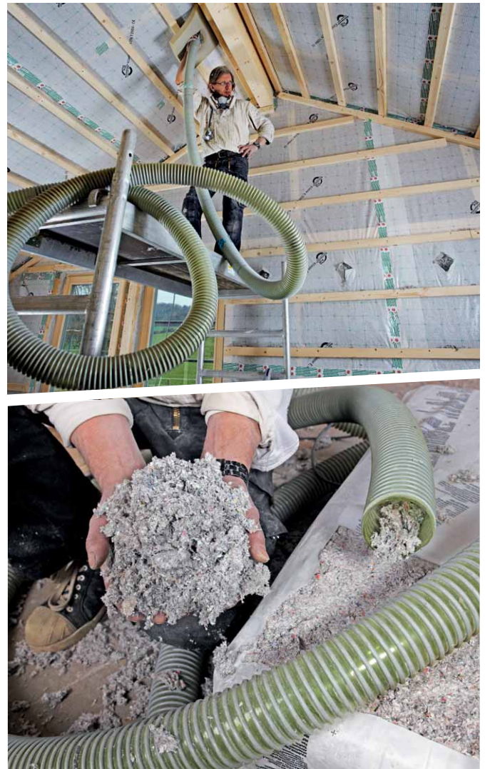
Einblasdämmung von Zellulose
