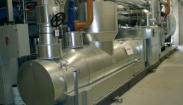
ORC-Modul zur Kraft-Wärme-Kopplung (Quelle: Stadtwerke Oerlinghausen)
