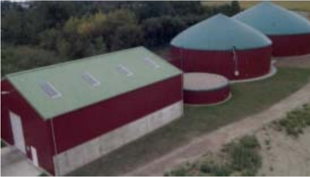
Die Biogasanlage im Wanzleben (Quelle: Stadtwerke Wanzleben)
