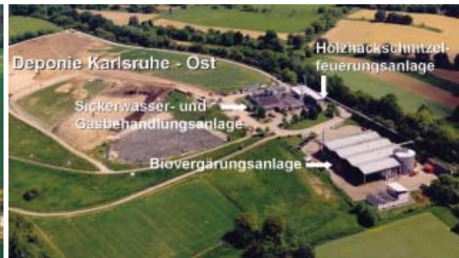
Der Anlagenverbund der Deponie-Ost (Quelle: AfA)
