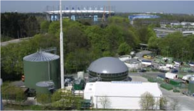
Die Biogasanlage vor der AOL-Arena, heute HSH Nordbank-Arena (Quelle: BioWerk Hamburg)
