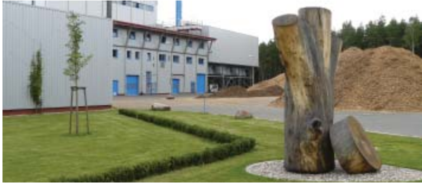
Der Rohstoff Holz in seinen verschiedenen Formen (Quelle: Stadtwerke Neustrelitz)
