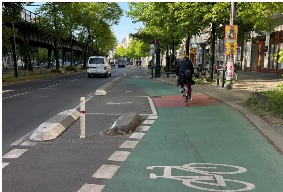
Abbildung 4: Bordsteine aus Beton zum Schutz von Radwegen (© DUH)
