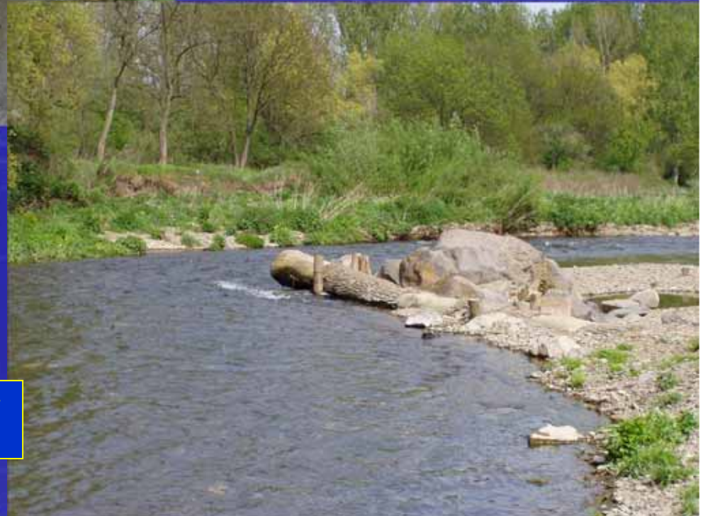
eingebrachter Strömungslenker Juli 2004
