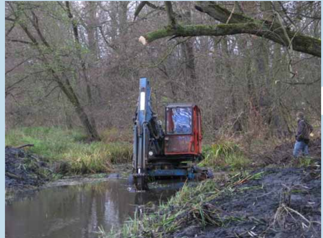
Entschlammung Oberlauf Krümmes Wehrfließ
