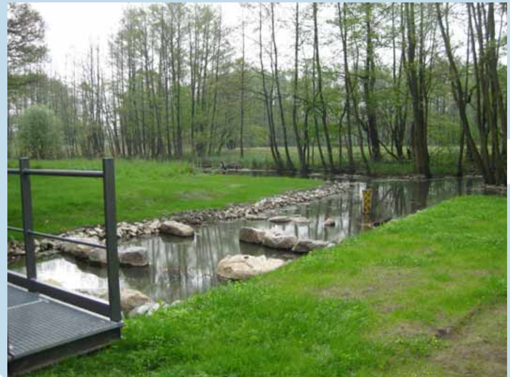
Steinschwellen für den Fischeaufstieg im Winterstau
