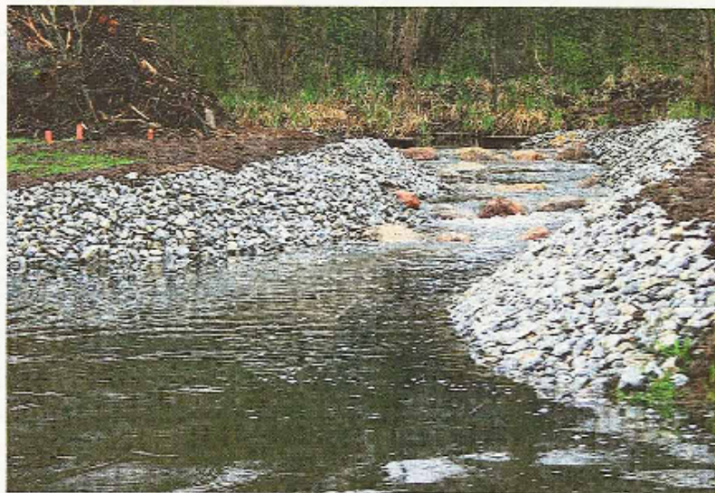
Ein neuer Fischwanderpass zu einem Forstgraben am Puhlstrom.
