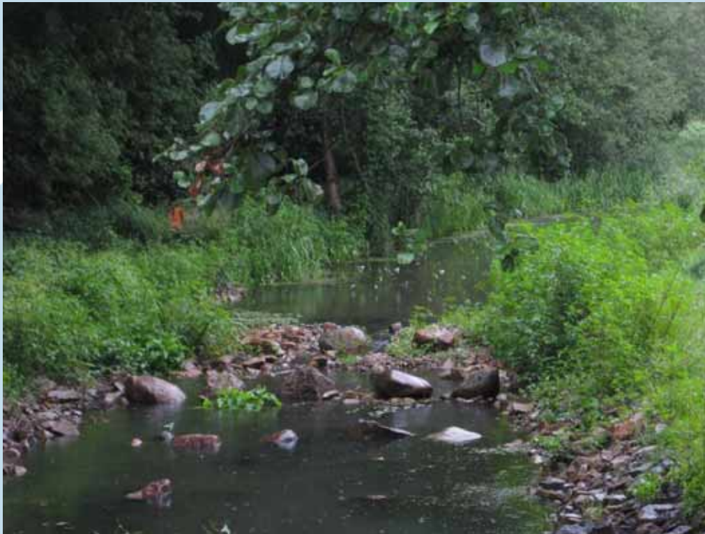
Steinschwelle zur Wasserstands-anhebung im Krümmen Wehrfließ
