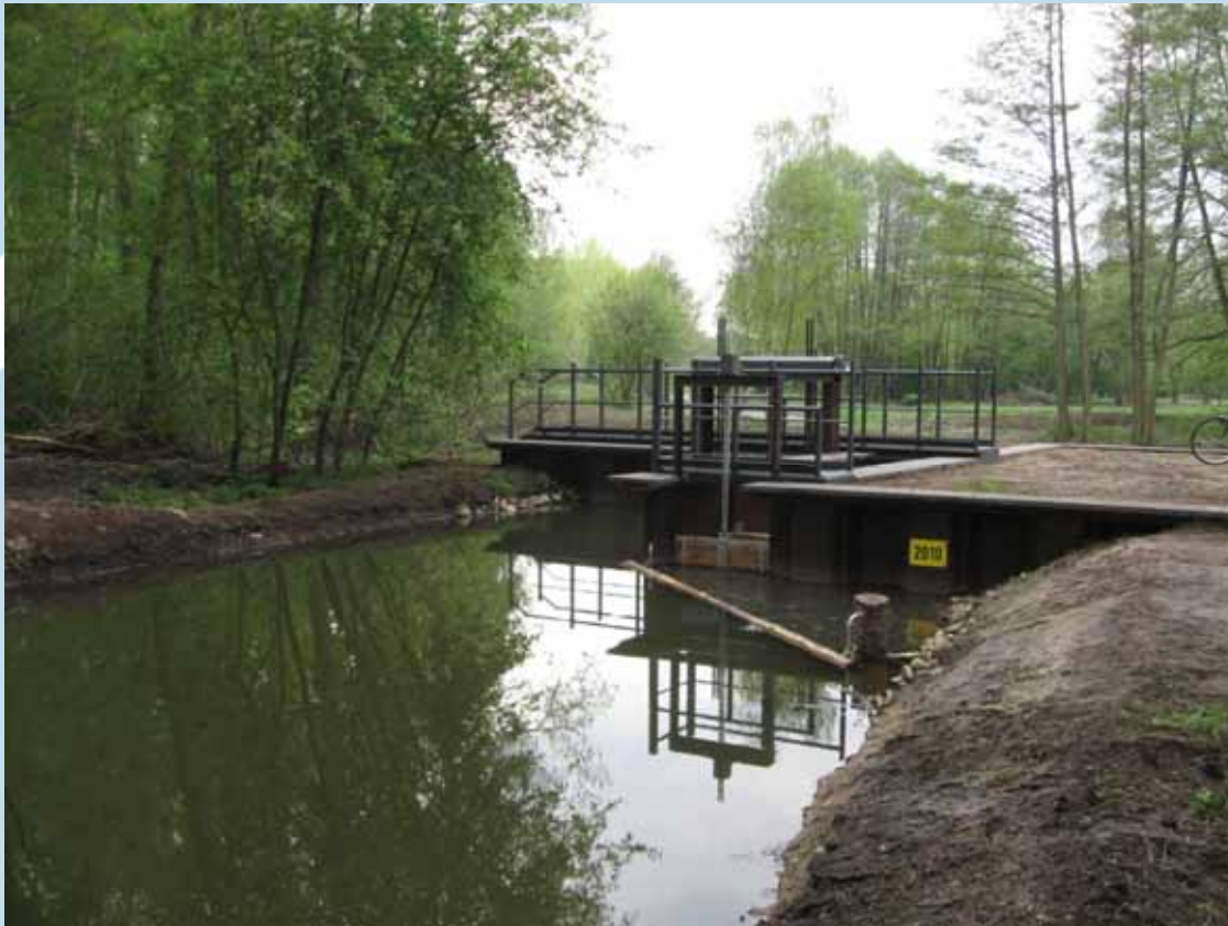
Ersatzneubau Wehr 35 am Einlauf Krummes Wehrfließ
