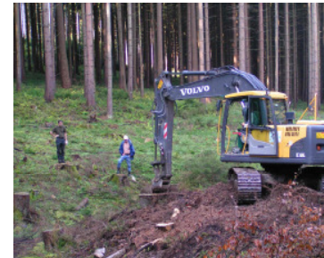
Schweres Gerät im Einsatz
