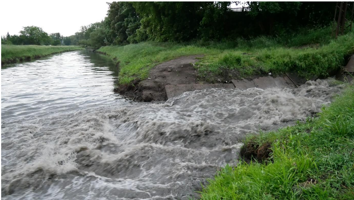
Fot. 13. Zrzut nieoczyszczonych ścieków kanałem burzowym do rzeki Iny w mieście Stargard.
