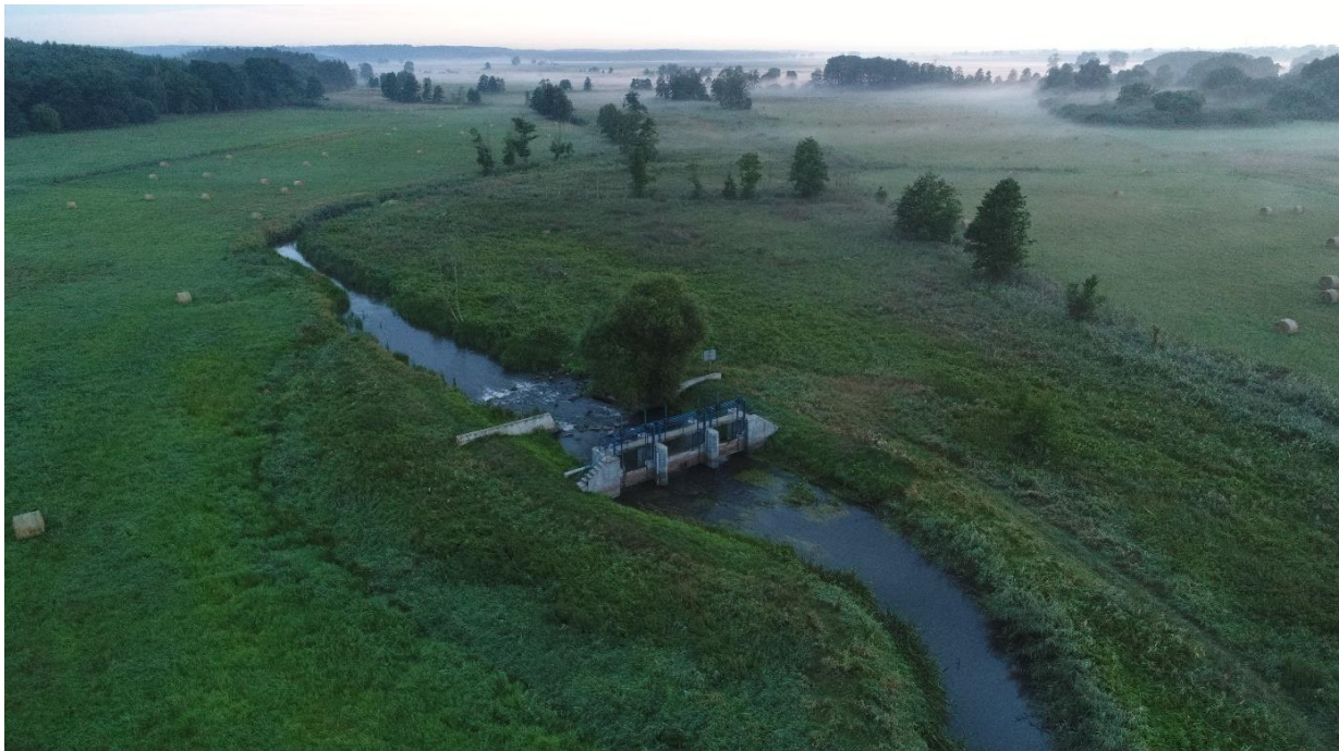
Fot. 5. Jaz piętrzący na rzece Inie na wysokości wsi Piasecznik.
