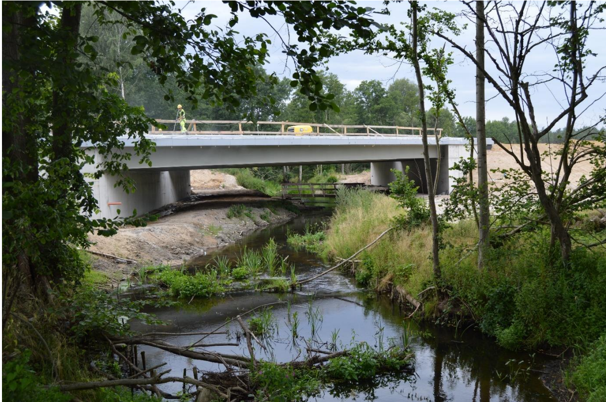
Fot. 15. Budowa nowego mostu na trasie S3, przecinającego Gowienicę w miejscowości Babigoszcz (fot. J. Krzystolik).
