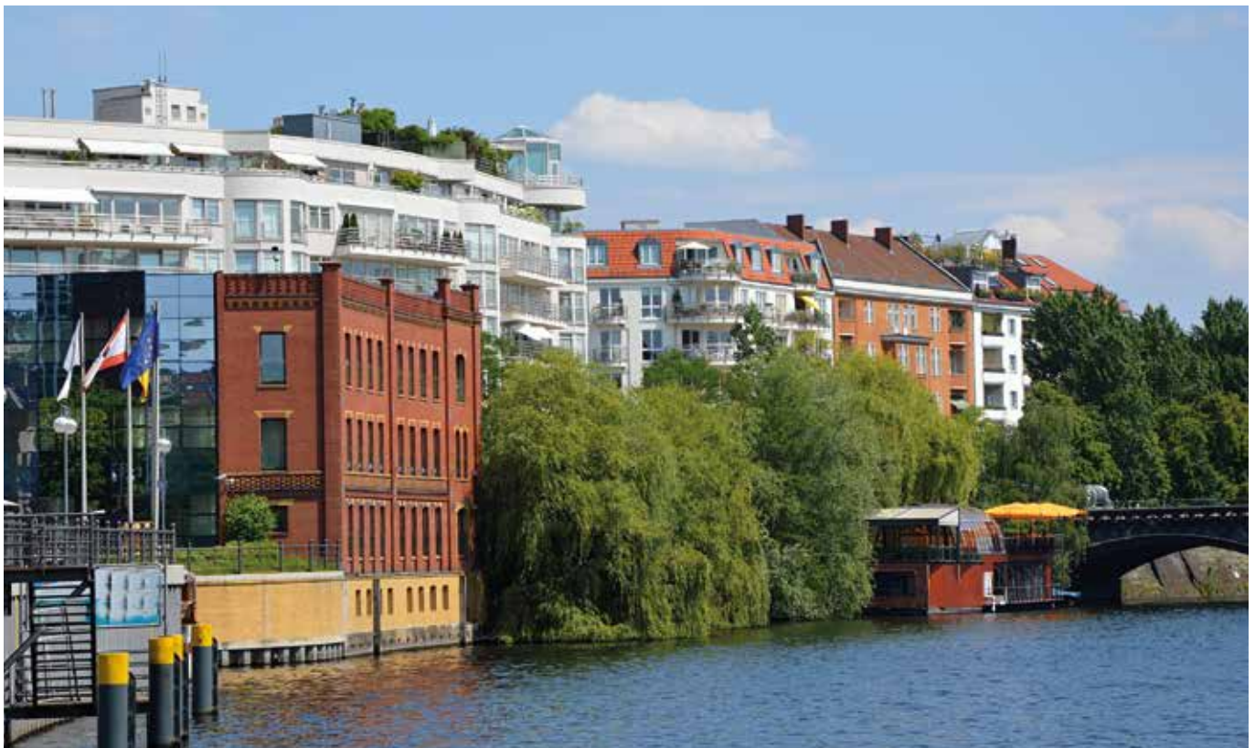
Zwischen endlosen Ufermauern bietet ein kurzer naturnaher Uferabschnitt für viele Tiere ein wichtiges „Trittsteinbiotop“, Ulf / AdobeStock
