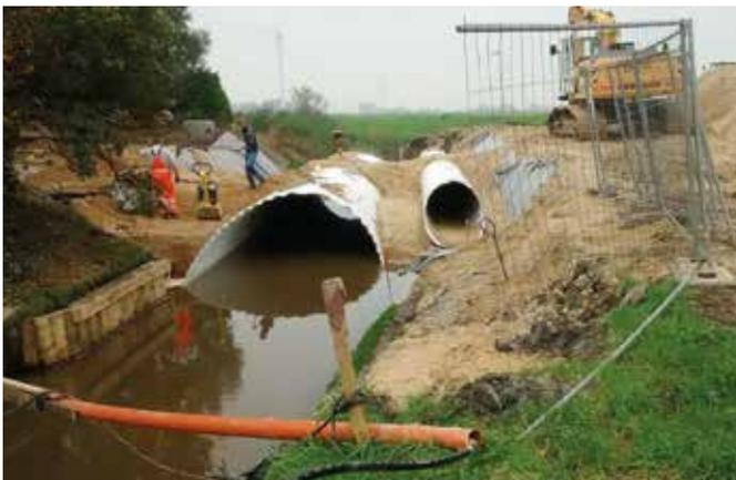
Abbildung 15: Hier erlaubt ein Trockentunnel neben dem eigentlichen Durchlass den Fischottern die Straßenunterquerung. Wobei der Einbau einer Berme in diesem Fall die optimalere Lösung wäre. (Foto: N. Knaak)
