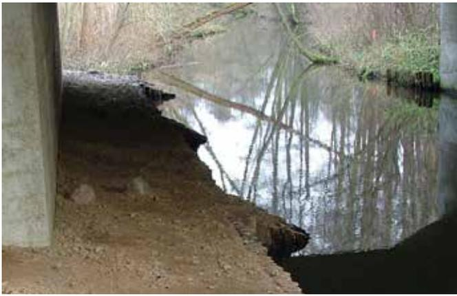
Abbildung 10: Nachträglich eingebaute Berme mit Aufstiegs- hilfen für Otter und andere Säugetiere an einer Spundwand (Foto: H.-H. Krüger)
