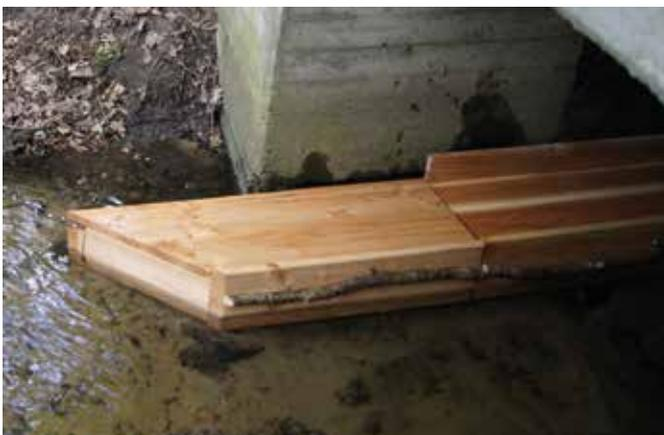
Abbildung 24: Schwimmbërme in Modulbauweise mit deutlich angehobener Lauffläche, wasserseitiger Aufstiegshilfe und abgeschrägter Spitze gegen die Fließrichtung (Foto: H.-H. Krüger)
