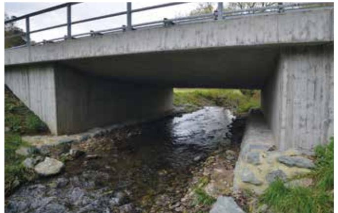
Abbildung 13: Im Fischotterschutz Thüringen Projekt wurden bei dieser Brücke Bermen in unterschiedlicher Höhe eingebaut (Foto: Flussbüro Erfurt)
