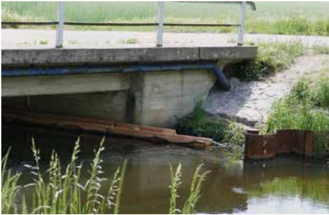
Abbildung 23: Anbindung einer Schwimmbërme im Drömling an das Ufer vor dem Brückenbauwerk durch ein zusätzliches, seitlich angebrachtes Modul. Die Spundwand lenkt Treibgut in die Flussmitte (Foto: DUH)
