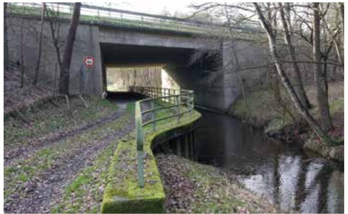
Abbildung 27: Die gleichzeitige Nutzung von Brückenbauwerken zur Durchleitung von kleineren Fahrwegen oder Fahrradwegen ist akzeptabel, sofern das Gewässer mit Bermen versehen ist. (Foto: H.-H. Krüger)
