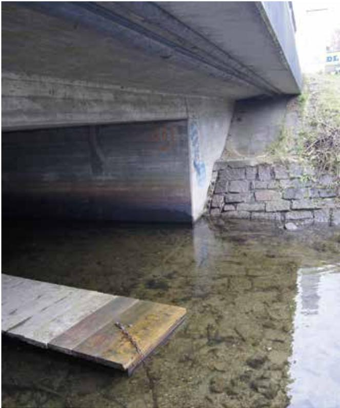
Abbildung 20: Eine einfache Form einer Schwimmbemme
