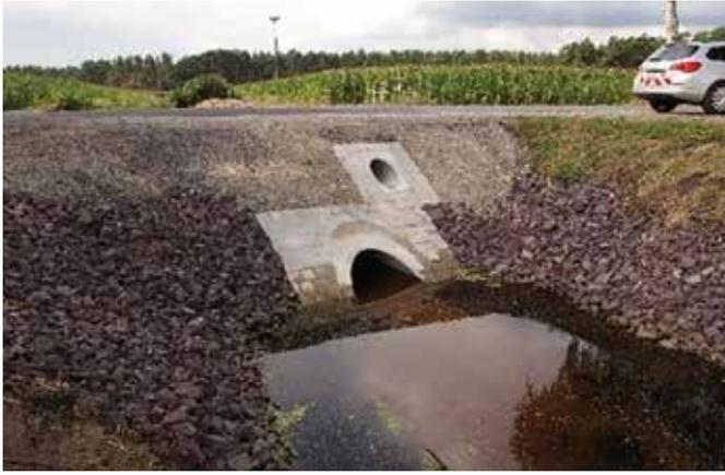
Abbildung 16: Ein Trockentunnel oberhalb des Wasserdurchlass, der auch bei Hochwasser die Durchgängigkeit für Fischotter und andere Tierarten sicherstellt. (Foto: H.-H. Krüger)
