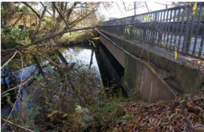
Abbildung 12: Der hohe Wasserstand lässt wenig Raum bis zur Brückendecke (Foto: H.-H. Krüger)
