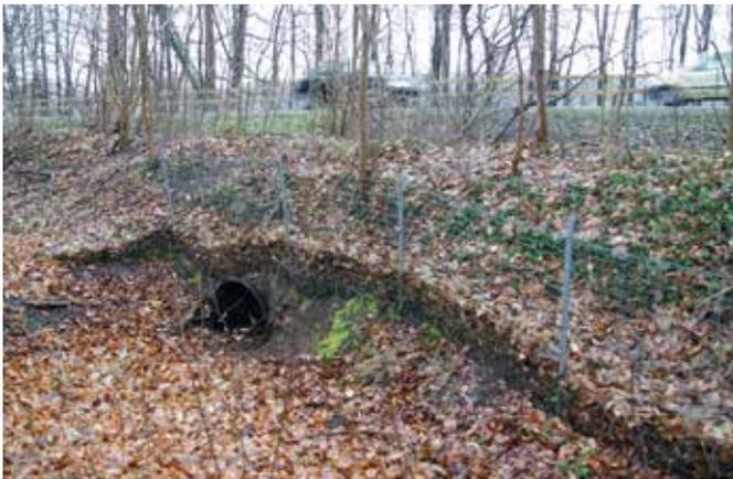
Abbildung 17: Ein Trockentunnel mit Leitzaunung zwischen zwei Seen in Schleswig-Holstein, der den Fischottern ein sicheres Queren der Straße erlaubt. (Foto: H.-H. Krüger)
