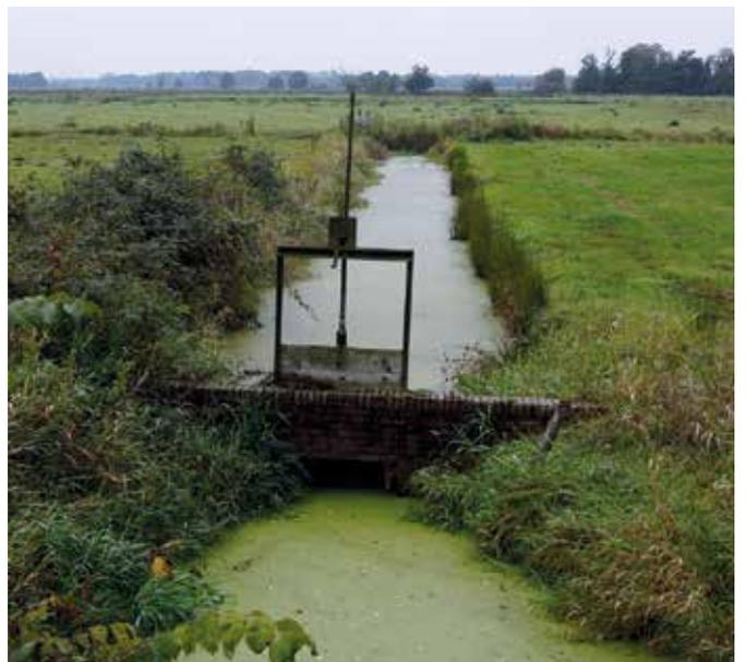
Abbildung 2: Kleine Sperrwerke regulieren die Wasserstände (Foto: H.-H. Krüger)
