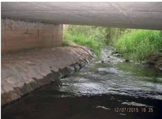
ABB. 30: NEU ERRICHTETE, GEMAUERTE BERME MIT RAUER OBERFLÄCHE (FOTO M. SCHMALZ)
