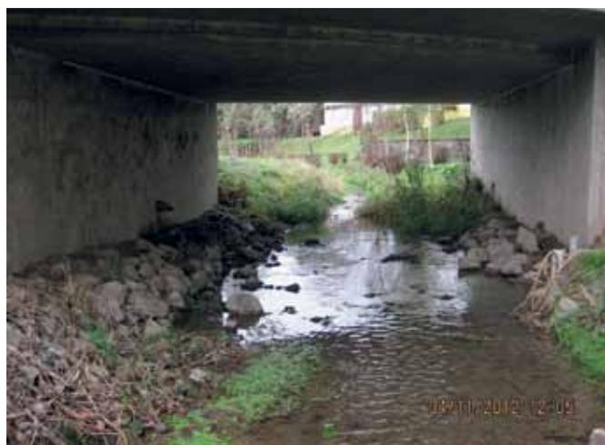
ABB. 9: EINFACHE STEINSCHÜTTUNG, DIE BEI HÖHEREM WASSERSTAND
