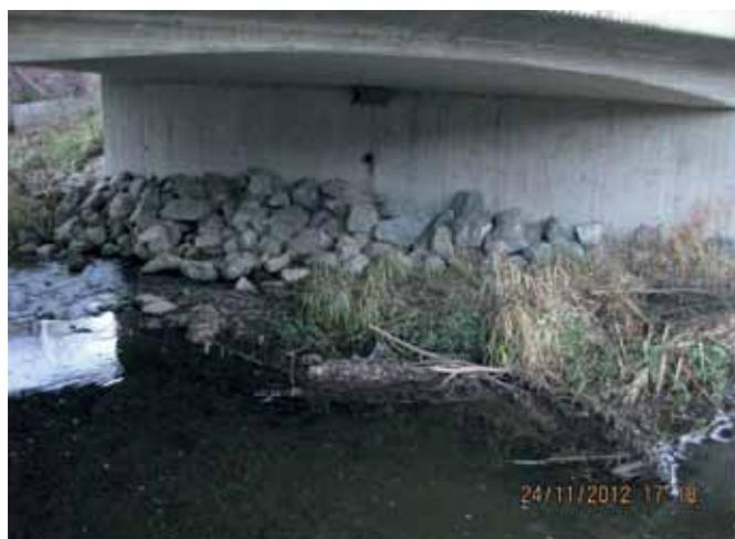
ABB. 10: ZU STEIL AUSGEFÜHRTE STEINSCHÜTTUNG OHNE EBENEN
