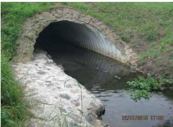
ABB. 34: GEMAUERTER UFERANSCHLUSS (FOTO M. SCHMALZ)
