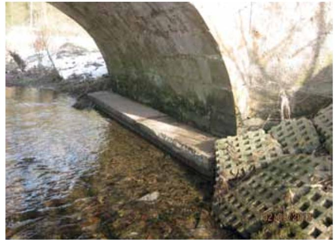
ABB. 18: ZU NIEDRIGER LAUFSTEG, DER BEREITS BEI MITTELWASSER
