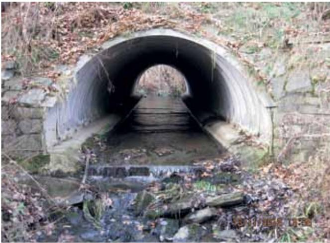
ABB. 32: BRÜCKE MIT BERMEN, ABER FEHLENDEM UFERANSCHLUSS (FOTO E. AYBOGA)
