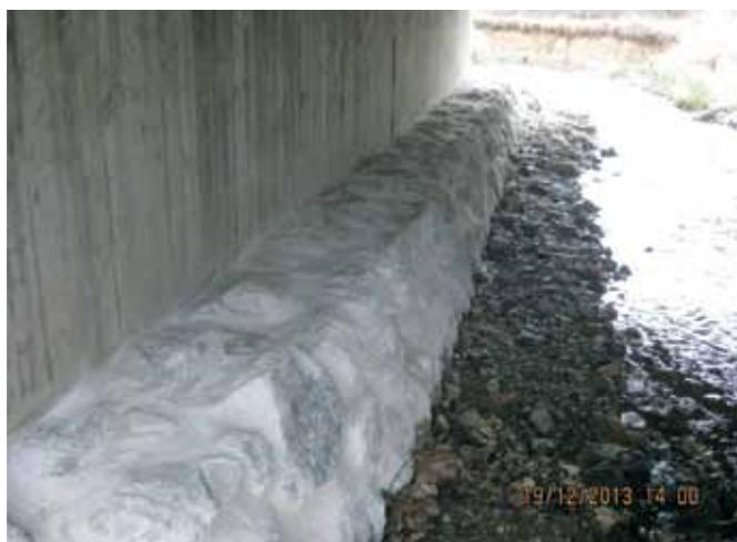
ABB. 13: ERHÖHTE BERME, DIE AUCH BEI MITTELWASSER NICHT ÜBERSPÜLT WIRD (FOTO M. SCHMALZ)
