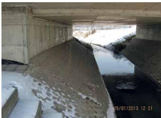
ABB. 14: STEILE NEIGUNG DER BERME, KEIN EBENER BEREICH. DIE RAUIGKEIT DER RASENGITTERSTEINE LÄSST DENNOCH EINE EINGESCHRÄNKTE NUTZUNG ZU (FOTO: M. SCHMALZ)
