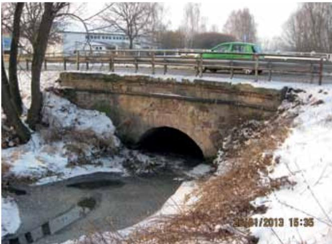
ABB. 26: HOHE GEFÄHRDUNG: BRÜCKE OHNE BERME, DIE ZUSÄTZLICH DURCH EINE STAUVOORRICHTUNG AUF DER ANDEREN SEITE EINGESTAUT WIRD (FOTO M. SCHMALZ)
