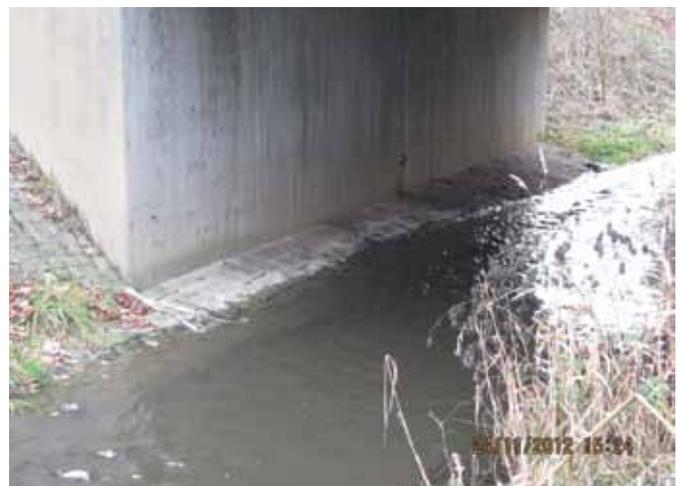
ABB. 25: MITTLERE GEFÄHRDUNG: SEHR FLACHE BERME, DIE BEI MITTELWASSER ÜBERSCHWEMMT WIRD (FOTO M. SCHMALZ)
