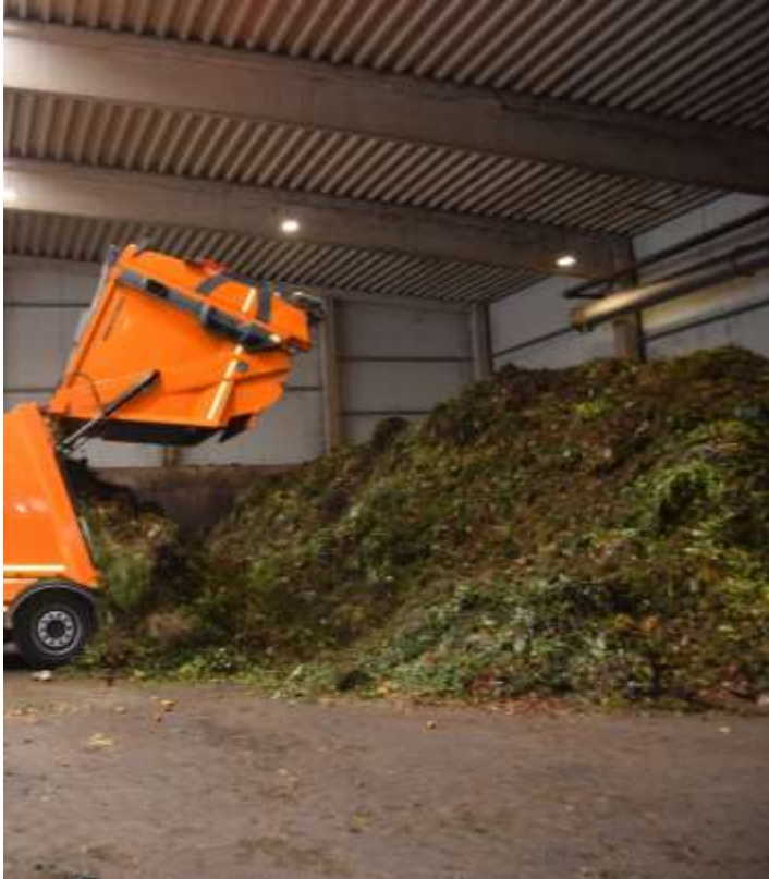
Abbildung 1: Anlieferungshalle der Kompostierungsanlage RSAG mit Bioabfall als Input für den Kompostierungsversuch
