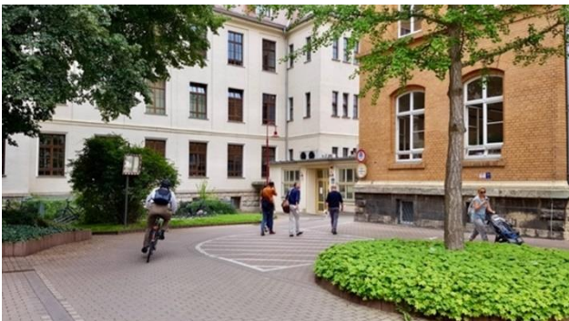
Abb. 70: Uniklinikum als zentrale Gesundheitseinrichtung (Foto: © ISP der FH Erfurt, 2021)
