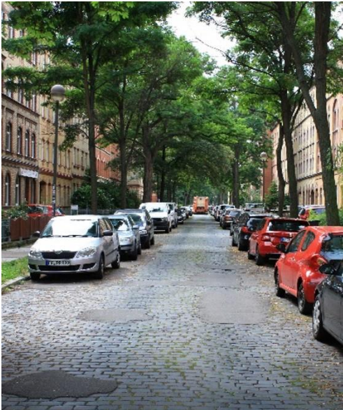
Abb. 16: Belagswechsel und Schlaglöcher auf der Nordstraße (Foto: © ISP der FH Erfurt, 2021)
