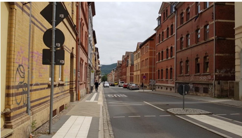
Abb. 76: Fehlendes Grün in der Lutherstraße (Foto: © ISP der FH Erfurt, 2021)
