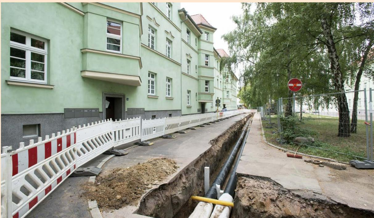
Abbildung 12 Straßenarbeiten zur Verlegung des neuen Nahwärmenetzes im Lutherviertel
