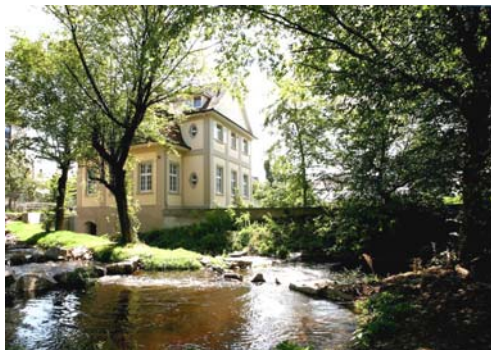
Wasserkraftanlage in Rastatt Foto: Stadt Rastatt
