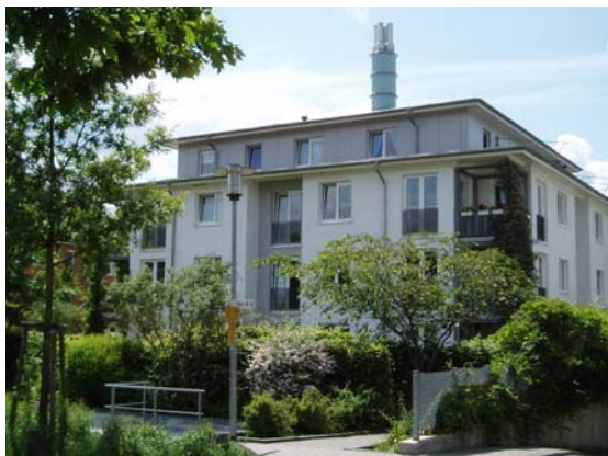
Blockheizkraftwerk integriert in einem Wohngebäude in Norderstedt
