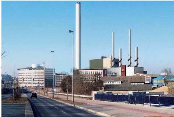
Das neue Gas- und Dampfturbinen-Kraftwerk in Münster
