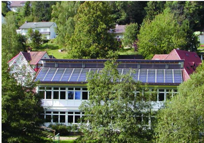
Solaranlage im Königsfelder Ortsteil Burgberg
