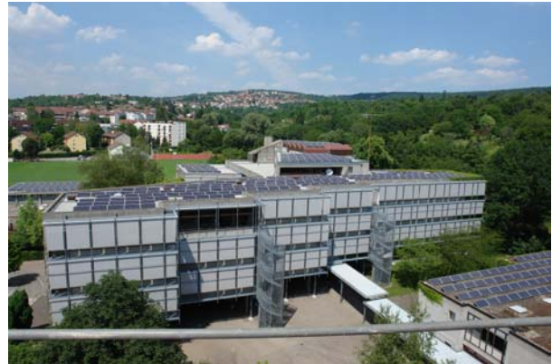
Solaranlage auf dem Dach des Theodor-Heuss-Gymnasiums in Esslingen Foto: Stadtwerke Esslingen
