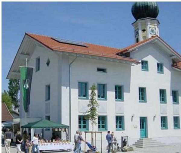
Rathaus der Gemeinde Ascha mit Solaranlage
