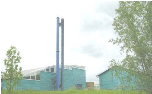
Biomasse-Heizkraftwerk in Ascha
