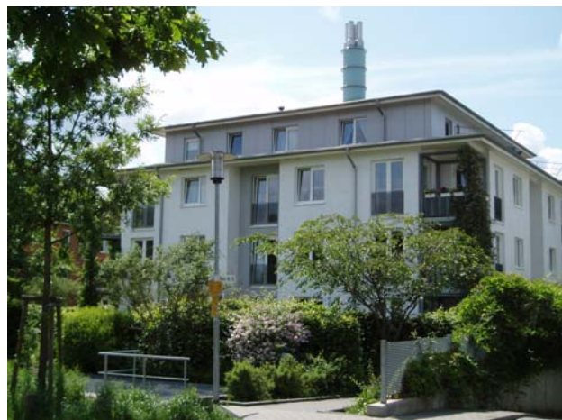
Blockheizkraftwerk integriert in einem Wohngebäude
