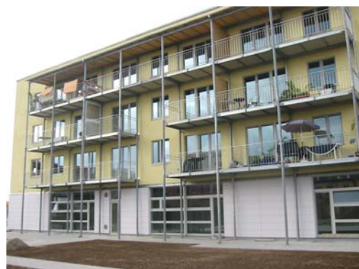
Passivhaus in München-Riem Foto: Fa. NEST Passivhaus GmbH, Unterhaching, Herr Nagel
