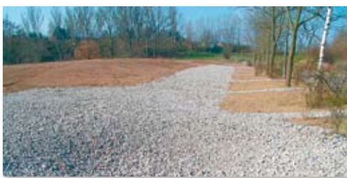
Die Fläche unmittelbar nach Aufbringen des Recyclingmaterials
