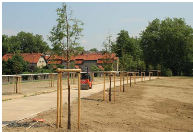
Ausbau des Emscher Park Radwegs im Biomassepark Hugo.
