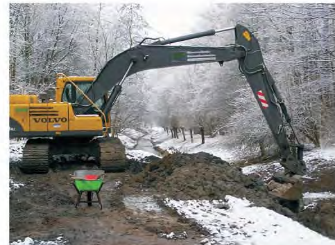
Bauarbeiten Bauabschnitt 5 in 2005
