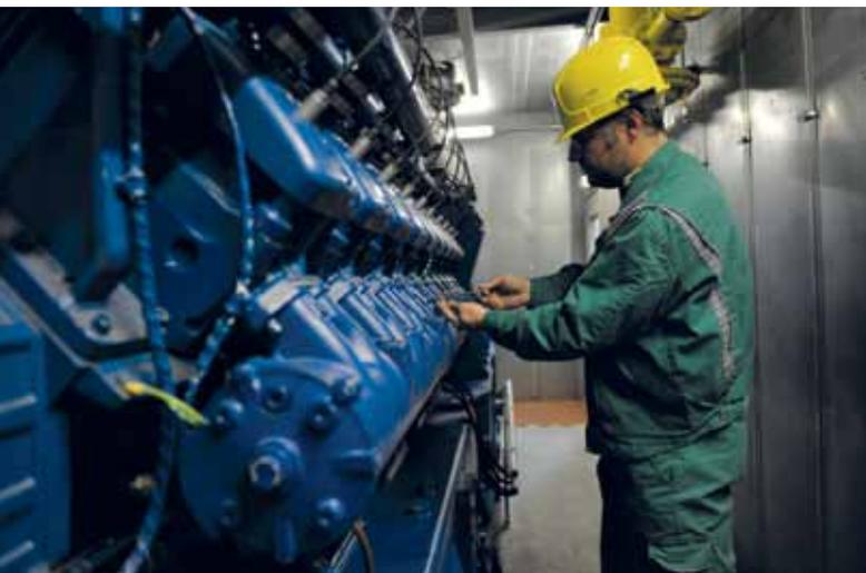
Mit Bioerdgas betriebener BHKW-Motor
