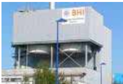
Illmenau 10 MW th / 10 MW el
