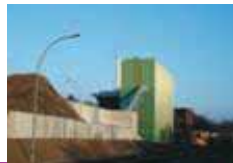
Neuwied 15 MW th / 7,5 MW el
