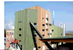
Buchen 8 MW th / 7,5 MW el
