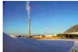
Erding 37,2 MW th
