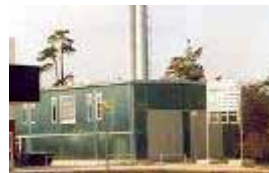
Unterschleißheim 31,2 MW th
