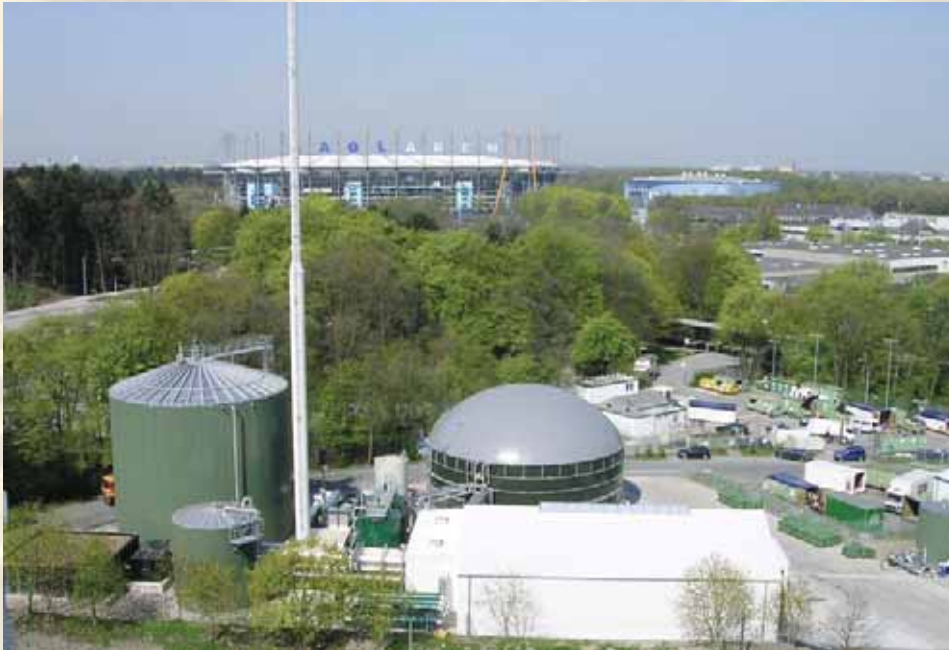
Eine Biogasanlage in Stadtnähe und damit in Nähe zum Wärmeabnehmer
