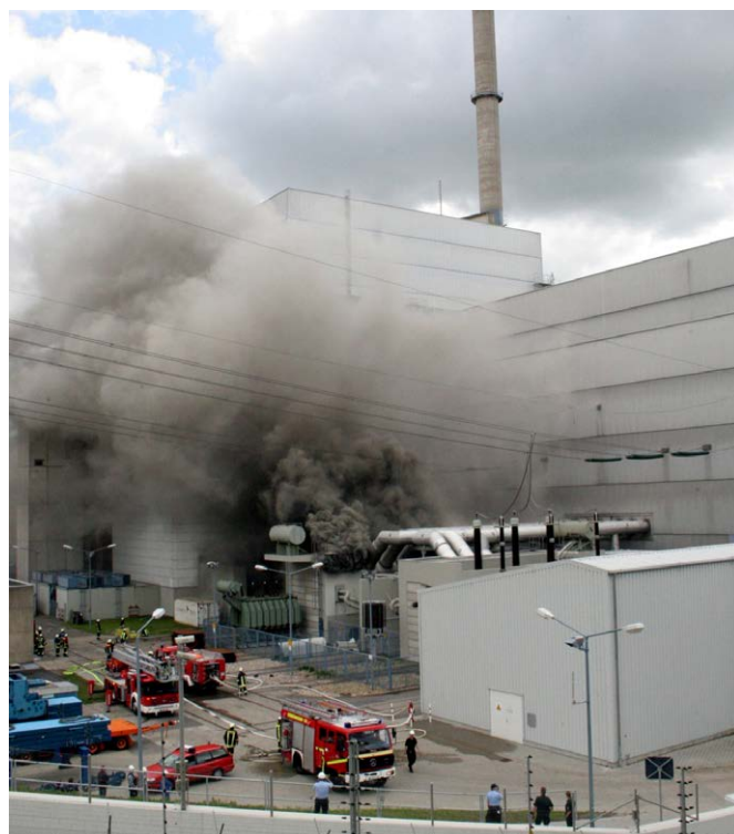
Abbildung 3: Löscharbeiten am Trafوهاus im Atomkraftwerk Krümmel, 2007.
