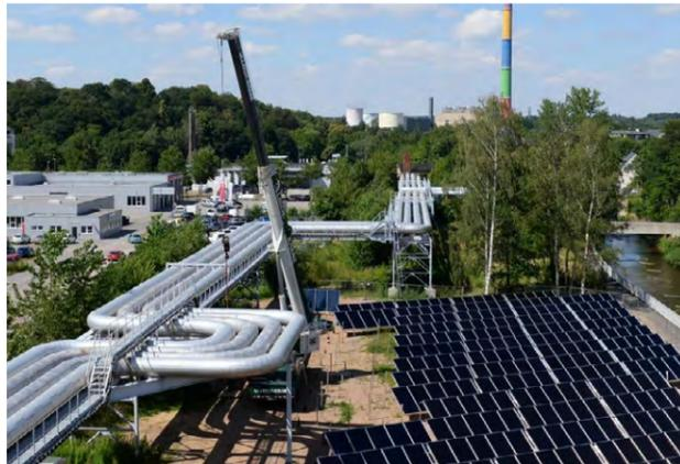
Abb. 14: Aufbau eines Feldes mit Großkollektoren – Solare Fernwärme Brühl in Chemnitz, © T. Urbaneck<sup>35</sup>
