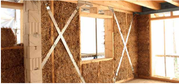
Fertig ausgefachtes Holzständerwerk mit Strohballen, gesichert mit Rispenbänden
