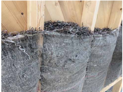
1. Verarbeitung von Schafwolle-Dämmung in einer Metallständerwand
