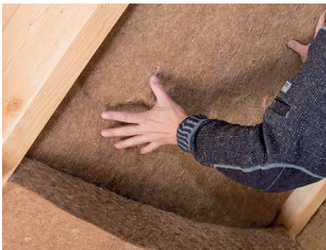
1. Verarbeitung von Schafwolle-Dämmung in einer Metallständerwand
