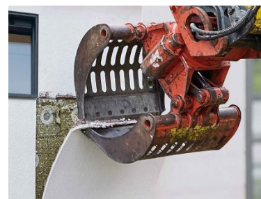
Abbildung 13: Beim Rückbau lässt sich der Putz, der in kleine Felder unterteilt ist, mit einem Bagger von der Dämmschicht lösen
