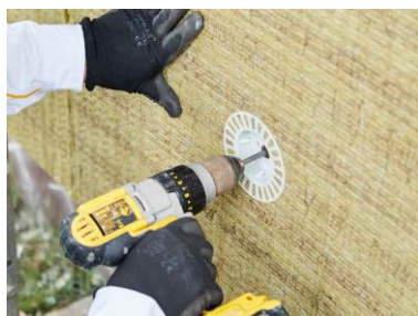
Abbildung 11: Montage der Dämmplatten mittels versenkbarer Schraubdübel
