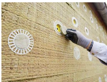
Abbildung 12: Durch Dübelrondele wird der Wärmeverlust verhindert.
