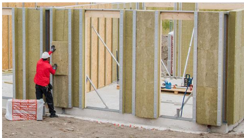
Abbildung 18: Aufbau von einem Rockzero Wandsystem
