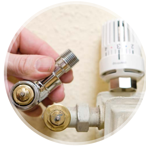
Abb. 1: Thermostatventil eines Heizkörpers; © ZVSHK
