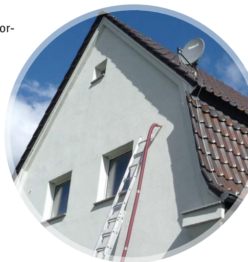
Abb 3: Nachträgliche Einblasdämmung eines zweischaligen Mauerwerks © v. Stein/einblasdaemmung.de
