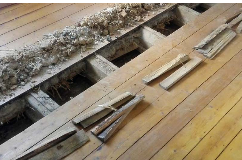
Abb. 2: Einblasdämmung Dielenboden im Erdgeschoss © v. Stein/einblasdaemmung.de
