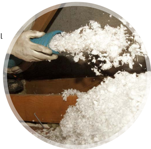
Abb. 1: Einblasdämmung © pass/Fotolia
