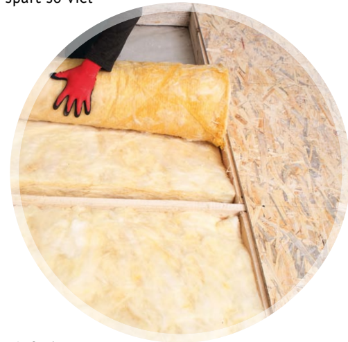
Abb. 1: Begehbare Dachboden © Smole/Fotolia
