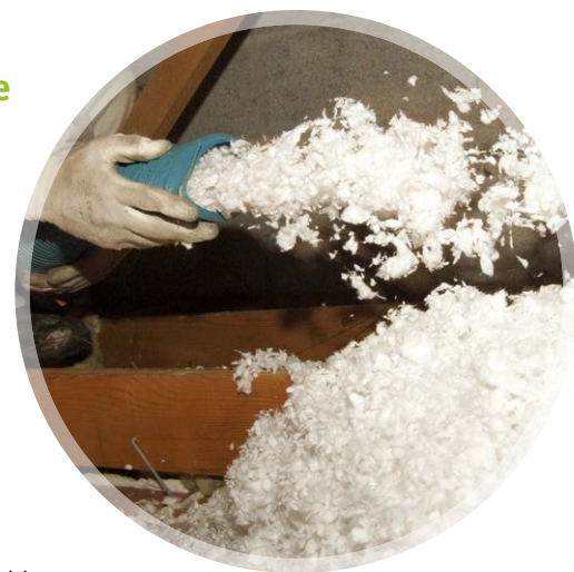
Abb. 3: Einblasdämmung © pass/Fotolia
