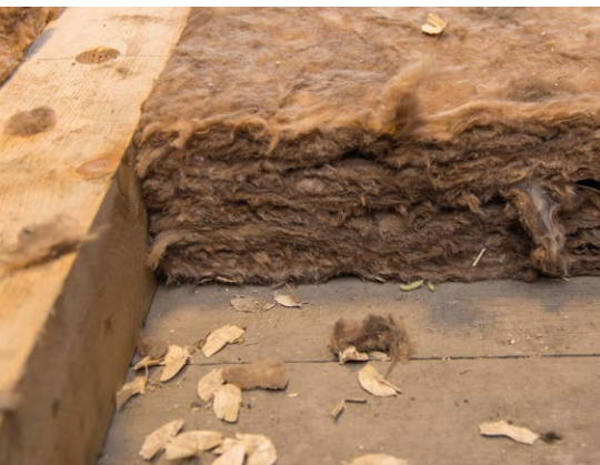
Abb. 2: Nicht begehbare Dachboden © Janni/Fotolia
