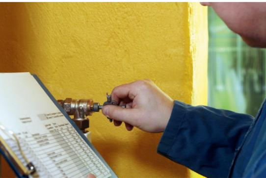
Abb. 2: Thermostatventil wird eingestellt; ©CO2online
