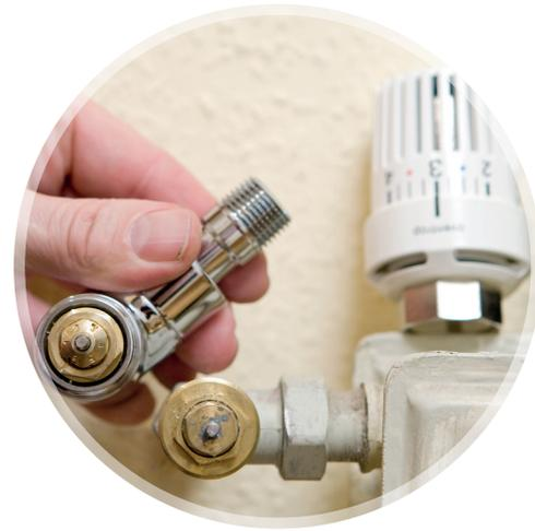
Abb. 1: Thermostatventil eines Heizkörpers; © ZVSHK
