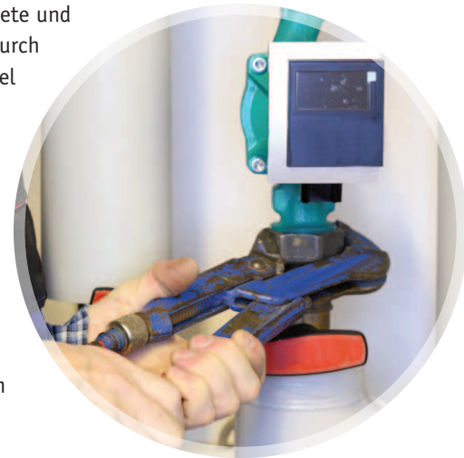
Abb. 1: Pumpentausch © rupbilder/Fotolia
