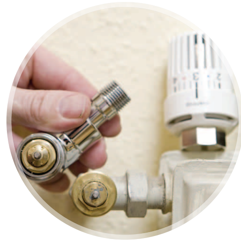
Abb. 1: Thermostatventil eines Heizkörpers; © ZVSHK
