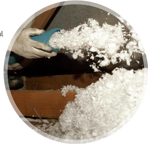
Abb. 1: Einblasdämmung
