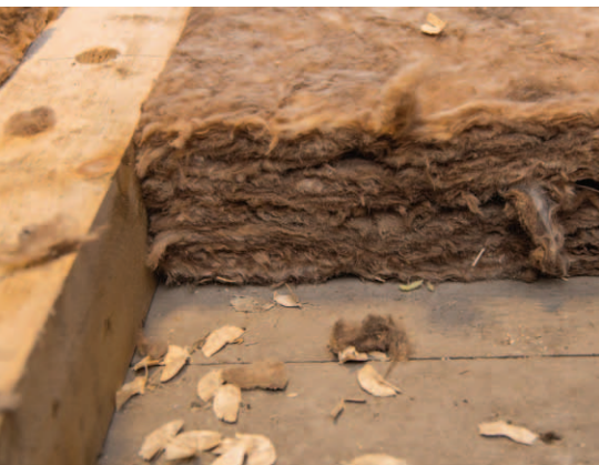
Abb. 2: Nicht begehbare Dachboden © Janni/Fotolia
