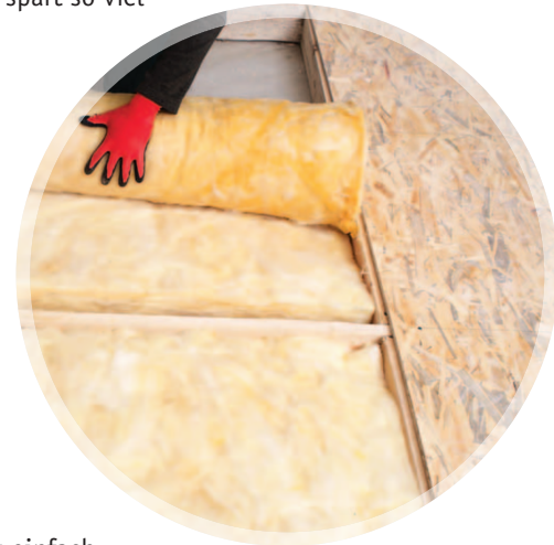
Abb. 1: Begehbare Dachboden © Smole/Fotolia
