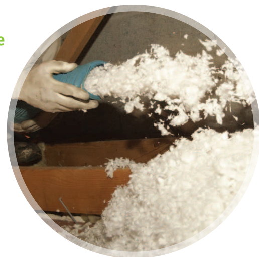
Abb. 3: Einblasdämmung © pass/Fotolia
