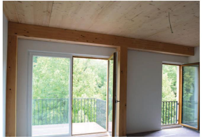
Abbildung 2: Innenansicht Wohnung mit Massivholzdecke
