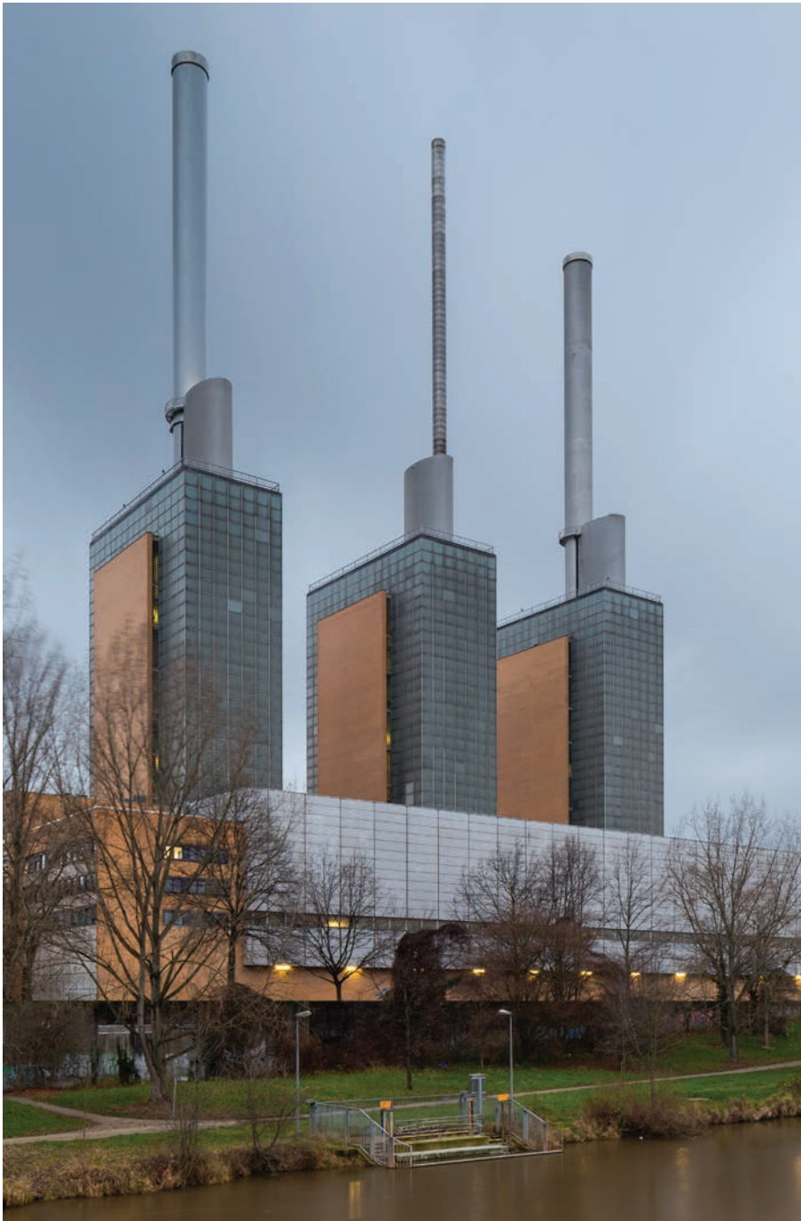
Gasbetriebenes Heizkraftwerk Linden in Hannover. Quelle: Christian A. Schröder (ChristianSchd) Wikimedia / CC BY-SA 4.0
