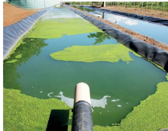
La Estrella: Die Kanäle sind schon gefüllt. Hier werden Wasserhyazinthen das Abwasser filtern.
