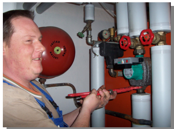
Einbau einer drehzahlgeregelten Heizungspumpe
