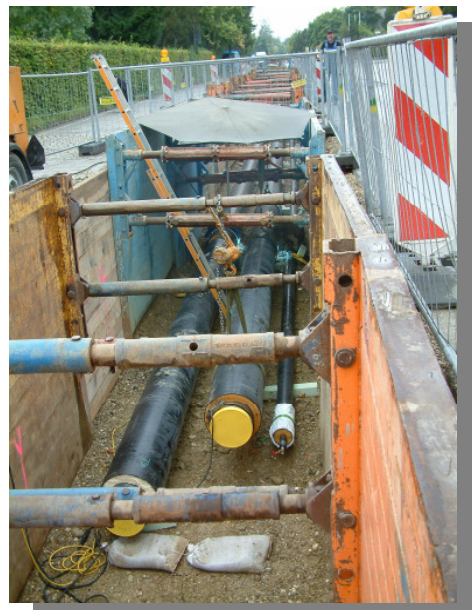
Bau der Fernwärmetrasse
