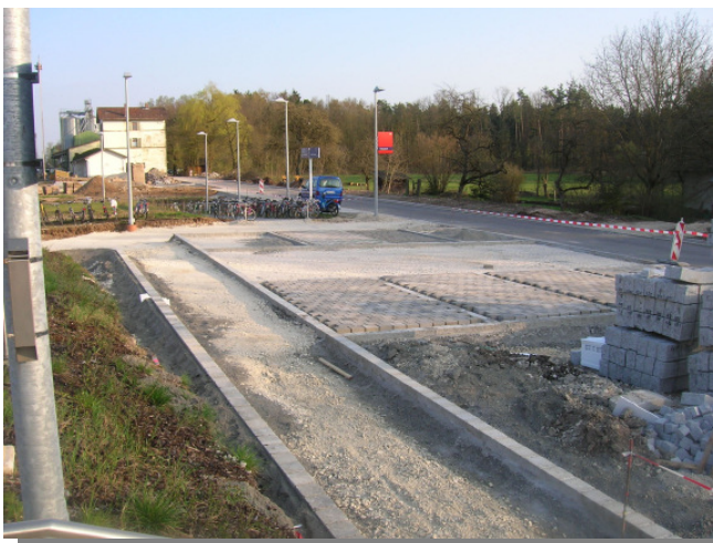
Baumaßnahmen am Bahnhof Triesdorf
