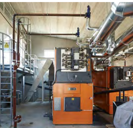
Biomassekessel in Büsingen
