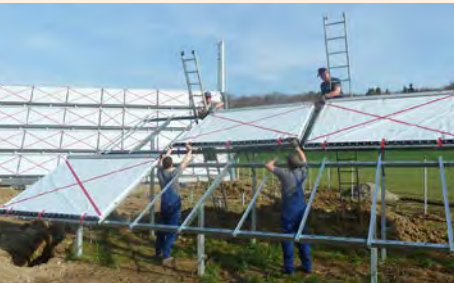
Freifeld-Kollektoranlage bei der Montage
