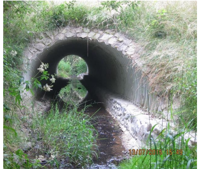
Abb. 4: Fischottergerechte Brücke mit eingebauter Berme.
