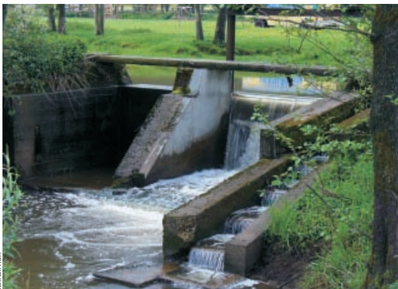
Herkömmliche Fischtreppe, für Fische weitgehend, für wirbellose Tiere vollkommen unüberwindbar
