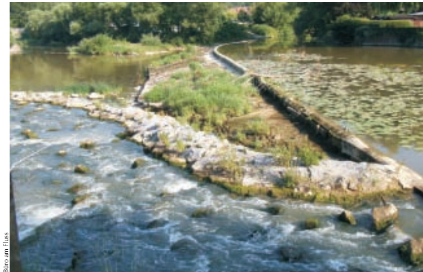
Ökologische Verbesserung des Gewässerabschnitts durch eine Teilrampe
