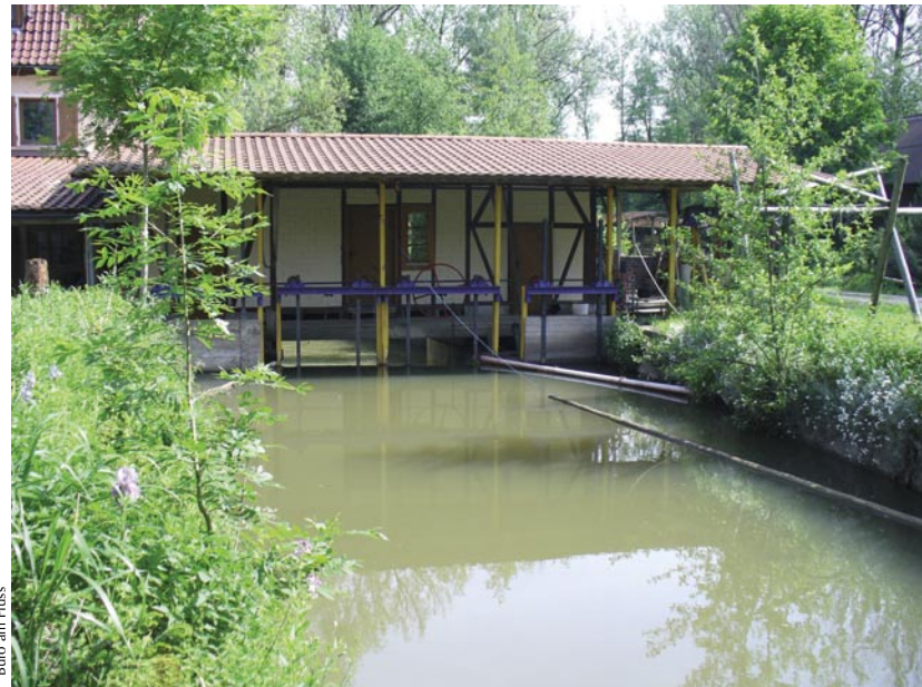
Die Bühler wird intensiv zur Gewinnung von Strom aus Wasserkraft genutzt, Kleinwasserkraftanlage im Kreis Schwäbisch Hall.
